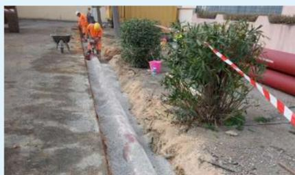
Ces deux rues, présentant un point de rétention d'eau, les travaux consistent à créer des puisards pour favoriser l'infiltration de l'eau dans le sol et effectuer des raccordements au réseau existant.
