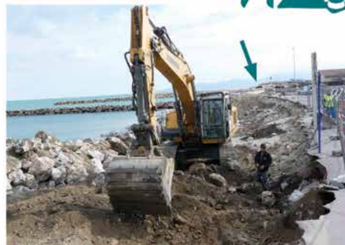
Dépose et évacuation des enrochements déstructurés constituant la digue de protection de l'ancienne plage.
