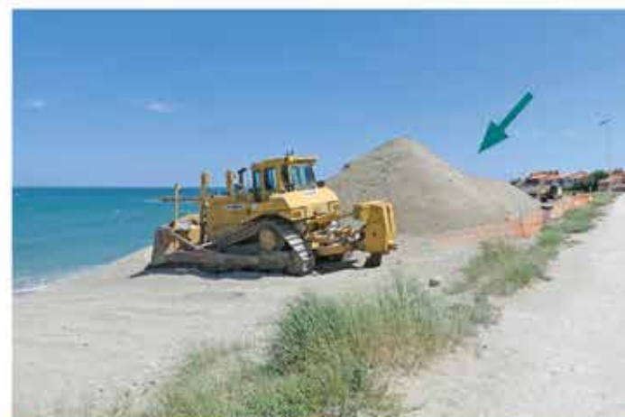
Pompage du sable depuis la passe du port jusqu'à après l'épi nord. Ce sable sera régalé sur la plage.
