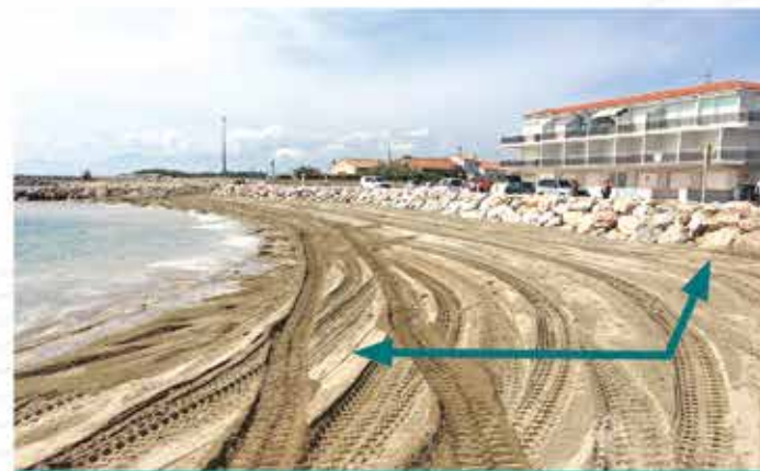
Mise en place de nouveaux enrochements constituant la digue de protection et rechargement en sable de l'ancienne plage
