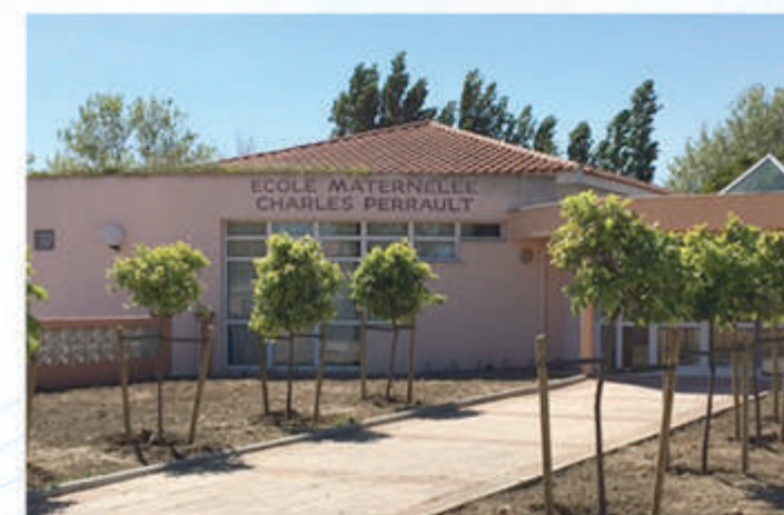
La climatisation sera installée dès cet été à la maternelle.
