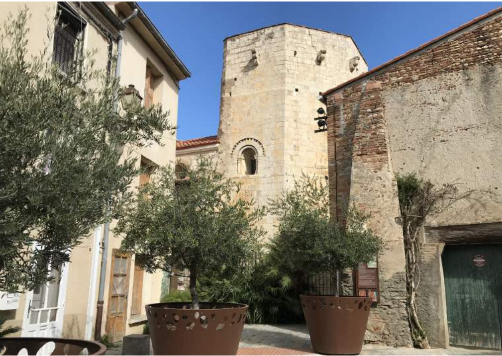
Abside médiévale avec des corbeaux pouvant supporter des hours.
