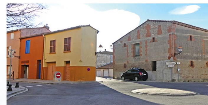
Médiathèque : la démolition des bâtiments débutera début Mai
