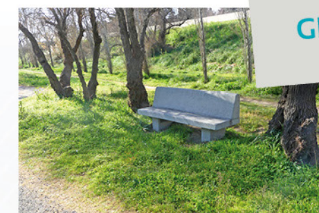
Mise en place de banc
