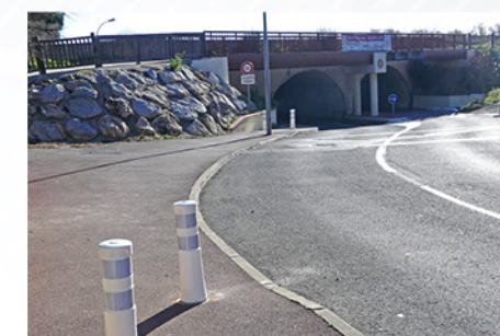
Sécurisation des buses
